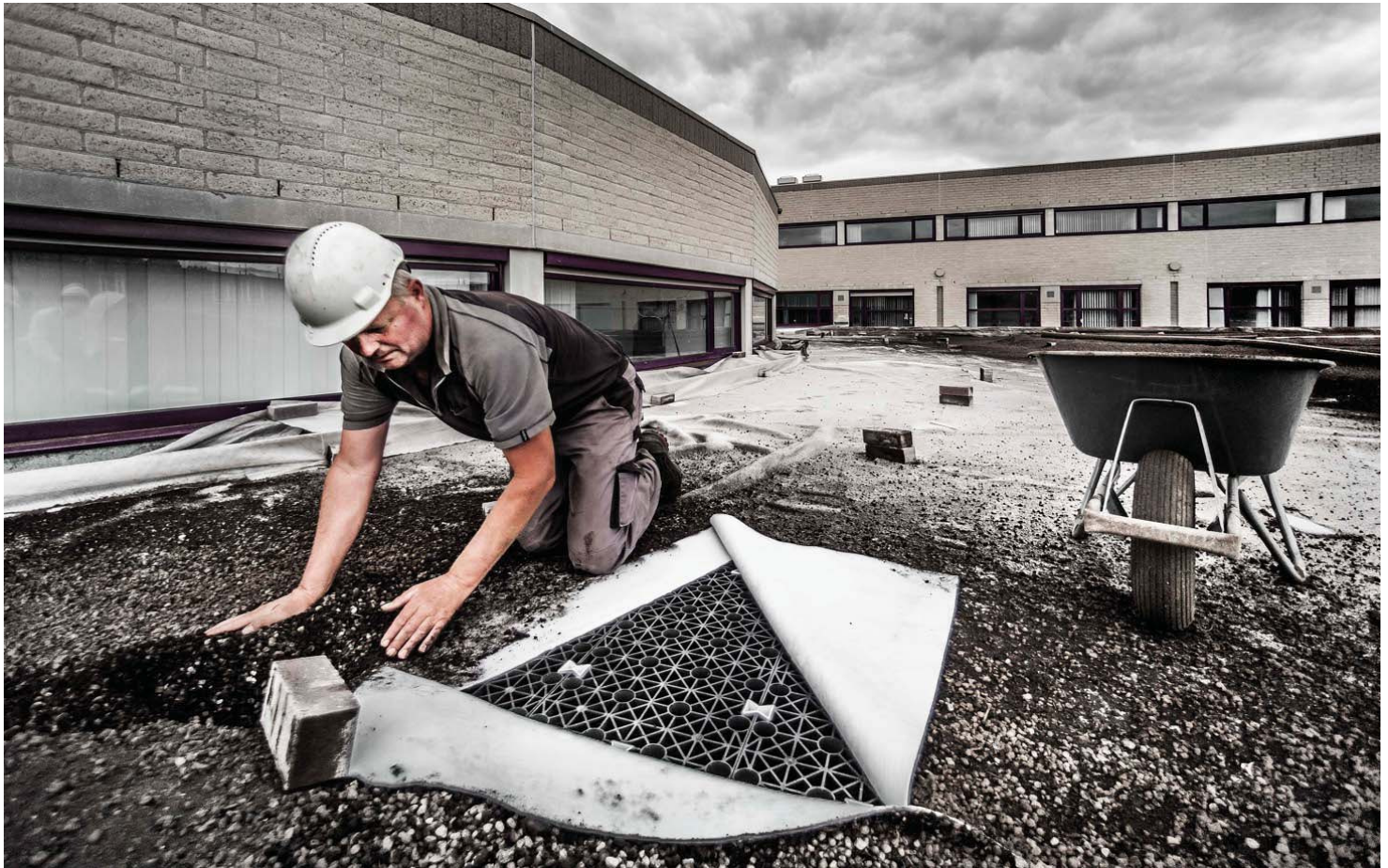
Opvangsysteem van diepe waterbergingskratjes met daarop een rooster, een wateropzuigend zeil en daar weer op lava en potgrond. In de herfst volgen de plantjes. FOTO ROGER DOHMEN
